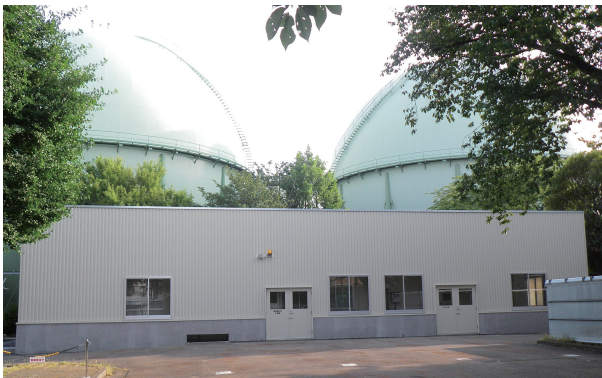
写真2 ガバナーステーション外観（補強工事後外壁面） Photo 2 Governor station after reinforce work (Outer wall)
