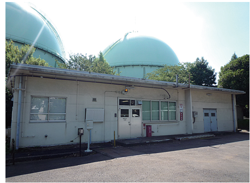
写真1 ガバナーステーション外観(補強工事前)
